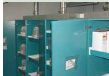
Oplag af mange dunke med opløsningsmidler. Dunkene er ubrudte, og de ventilerede kemikalieskabe nedsætter risikoen for, at der opstår eksplosiv atmosfære. Rummet skal ikke zoneklassificeres
