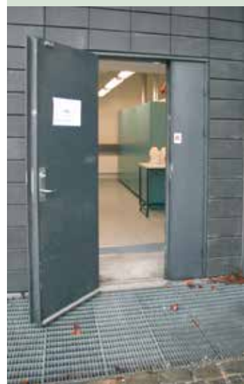
Niveaufri adgang til kemikalielager
