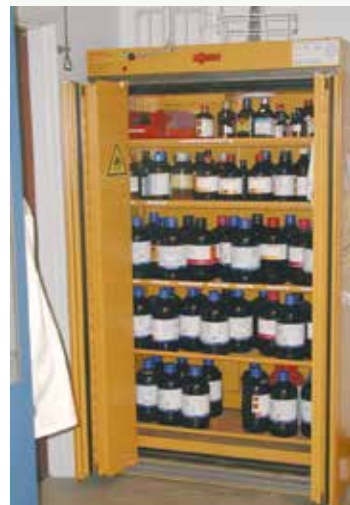
Brandsikkert skab med udsug og sikring, der automatisk lukker skabet i tilfælde af brand. Hvis emballagerne er tæt lukkede og luftskiftet min. 1 gang/time (her i hele lokalet) giver det ingen zoneklassificering
